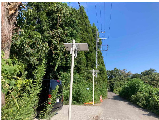
ゲート前に設置されているソーラーシステムと長距離 AP
